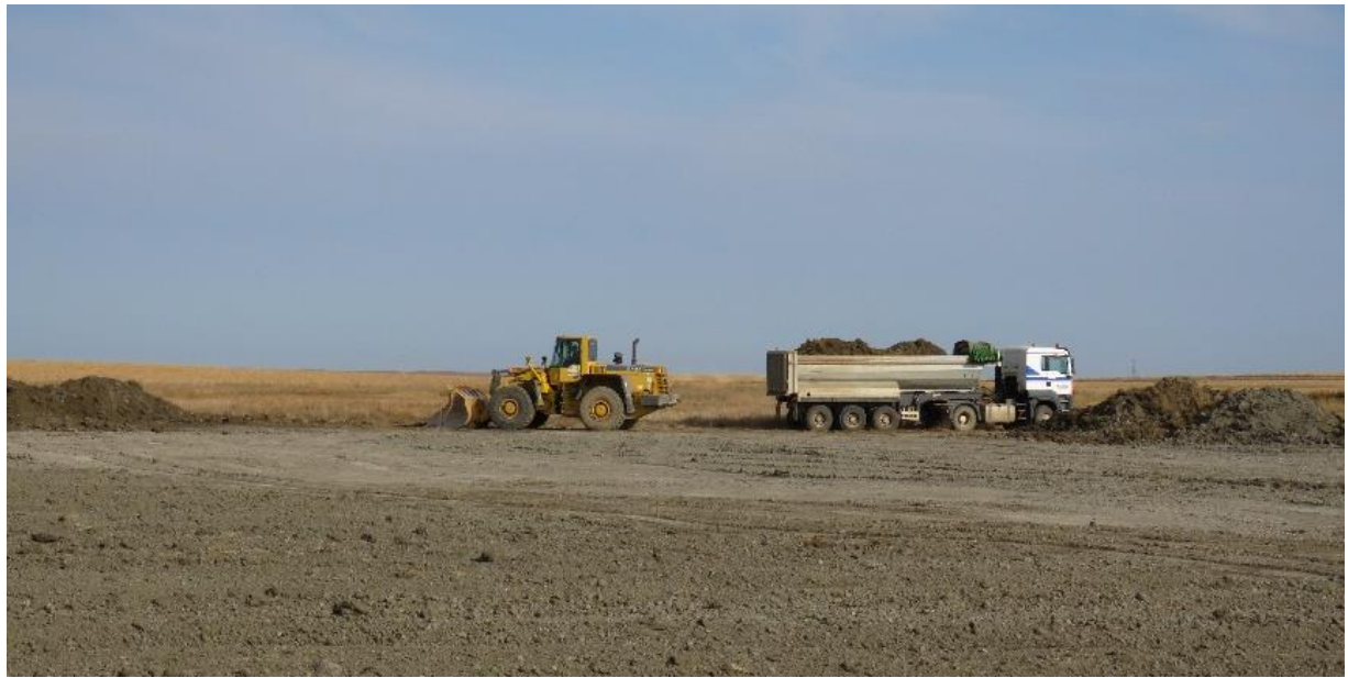
Trabajos de decapado
